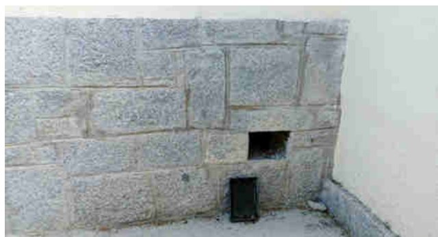
Figura 4 - Abertura de ventilación existente
