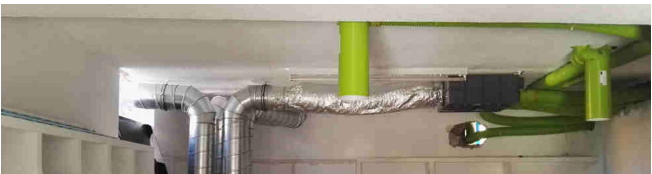
Figura 8 - Red de conductos de impulsión y expulsión
