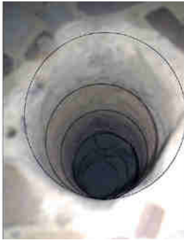
Figura 2 - Sección de la solera y el sustrato (arriba.) y perforación en solera y sustrato (abajo)
