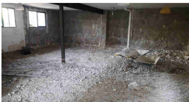
▼ Figura 5 - Demolición de la solera existente
