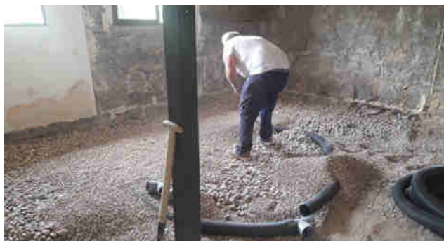
▼ Figura 6 - Instalación de los tubos perforados y de la capa de grava
