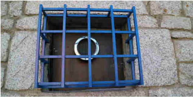
Figura 4 - Boca de toma de aire en la fachada
