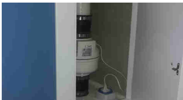
▼ Figura 8 - Extractor instalado en un armario de uso exclusivo
