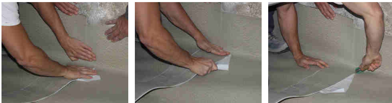
▼ Figura 10 - Sellado del solape entre dos láminas
