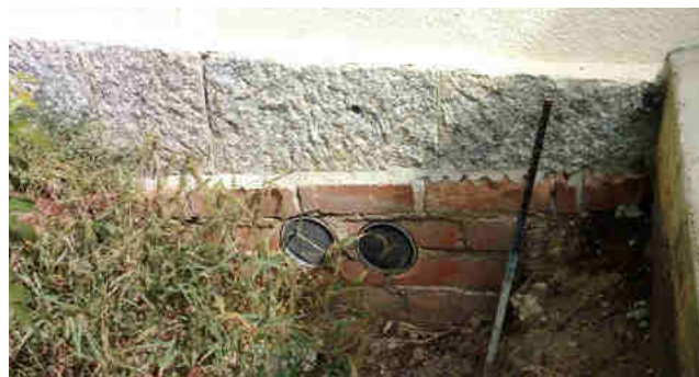
Figura 7 - Aberturas de ventilación finalizadas con rejillas
